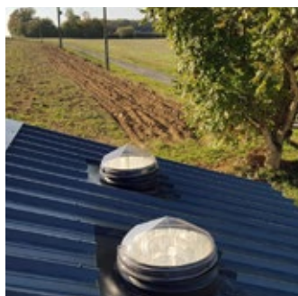
1- Aplicação em painel sandwich
