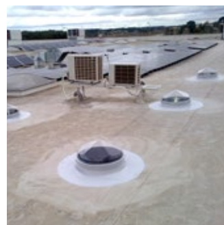
2- Cobertura Deck, revestimento em tela de pvc
